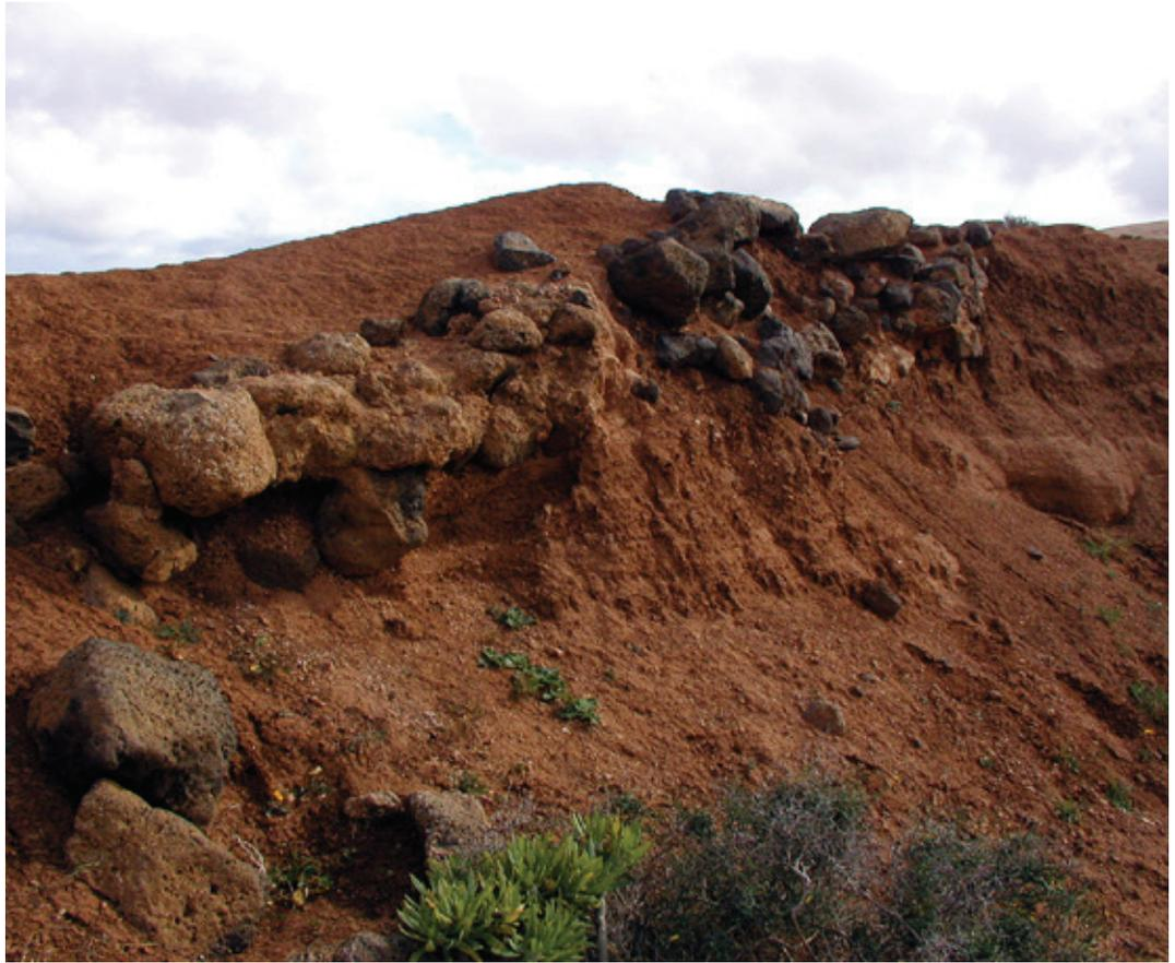
Detalle del teste de tierra y piedra que suele conformar los muros de contención de las maretas.
