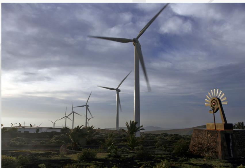
Inicialmente se instalaron 42 aerogeneradores American Wind Power-AWP-56 de 100 kw de potencia nominal; y 6 aerogeneradores MADE E-23 de 180 kw de potencia nominal. Los cuales generaban una producción anual media de 12.000.000 kwh.
